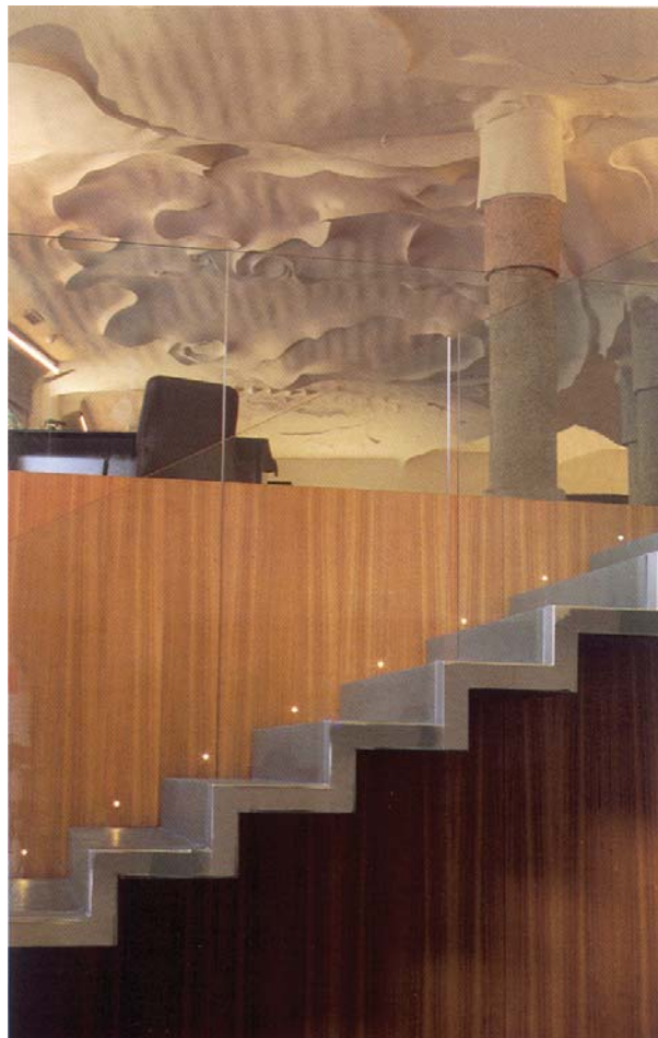
Balizamiento lateral escalera
